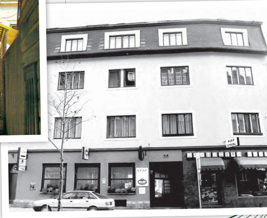
Die Fassade des Hotel-Gasthof Graf bevor 2008 der heutige Lounge-Bereich dazukam.
